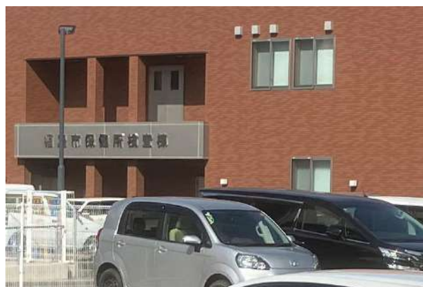
福島市保健所検査棟
